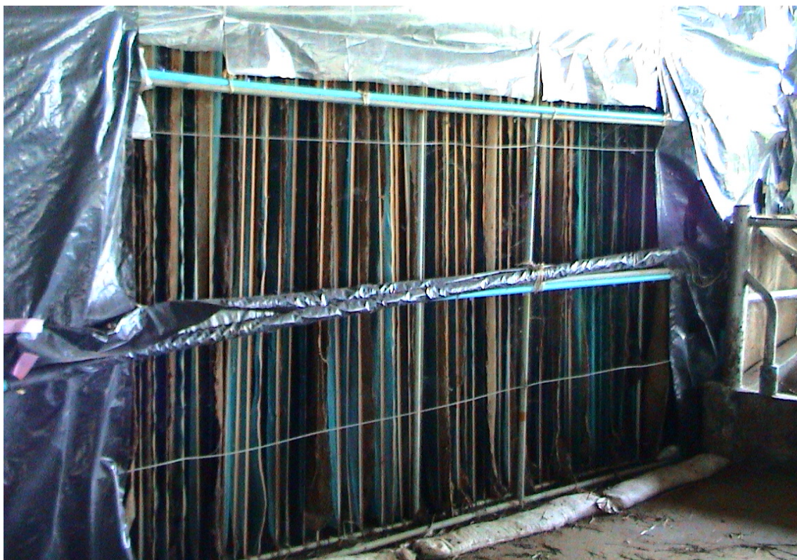
รูปภาคผนวกที่ 7 กระสอบป่านที่ถูกดัดแปลงเป็นรังผึ้ง หรือ cooling pad
