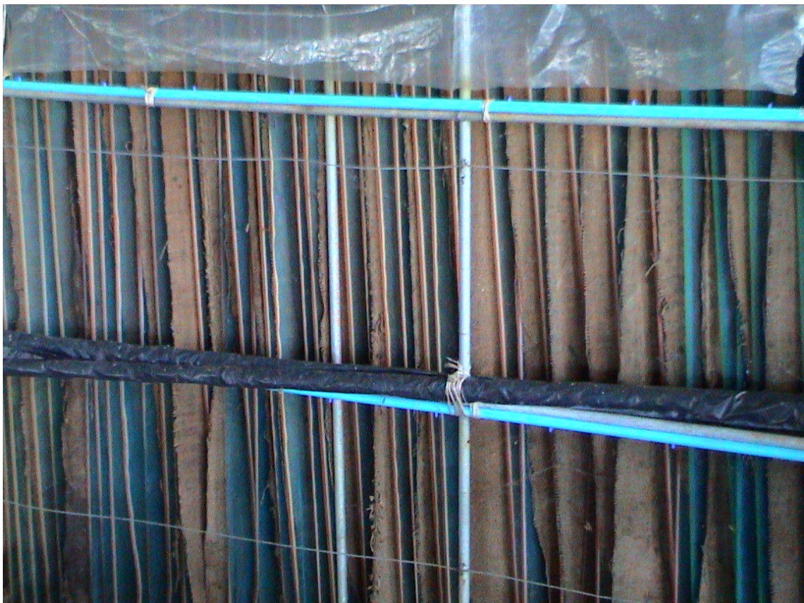
รูปภาคผนวกที่ 6 กระสอบป่านที่ถูกดัดแปลงเป็นรังผึ้ง หรือ cooling pad
